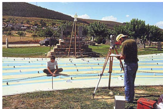
Figura 23. Replanteo (desde el borde norte) de los analemas de las horas en punto.
