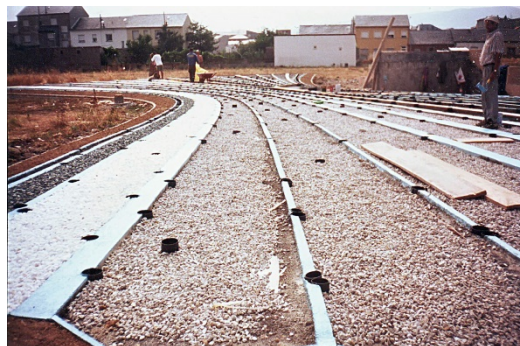
Figura 12. Las obras duraron en Bembibre 9 meses. En la imagen se aprecian las "bandas de recrecimiento", que son un elemento esencial e imprescindible.
