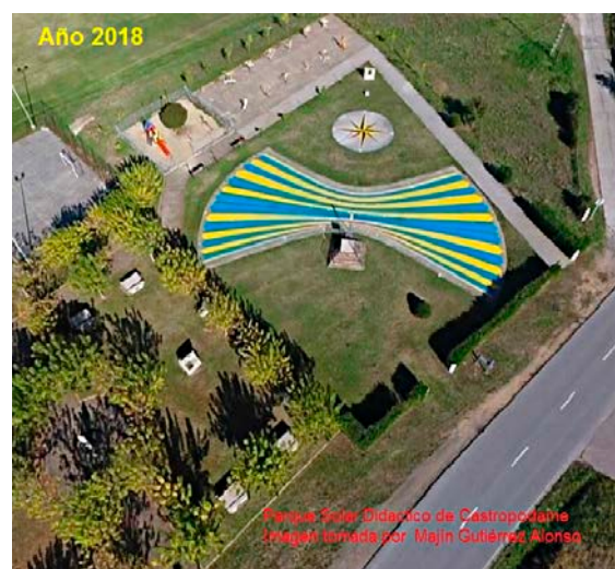
Figura 28. Vista general (a vuelo de dron) del Parque. Se observa el podio para su correcta visión, el cuadrante principal, la rosa de los vientos y la posición de los dos relojes de sol convencionales (fotografía de Majín Gutiérrez Alonso).
