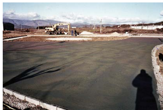
Figura 20. Recuperación del Parque Solar de Castropodame. Obras en 2005. Solera de hormigón.
