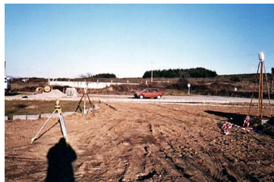
Figura 19. Recuperación del Parque Solar de Castropodame. Obras en 2005. Explanación del terreno.
